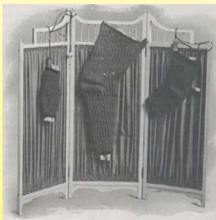
1910 Vêtements chauffants Herrgott à usage médical (Archives d'électricité médicale du 25 Aout 1910). On peut y voir clairement l'existence de nappes de cordes chauffantes cousues.
